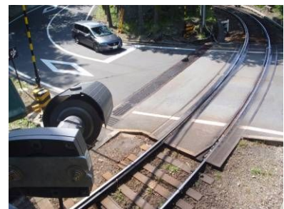
踏切保安度向上工事
