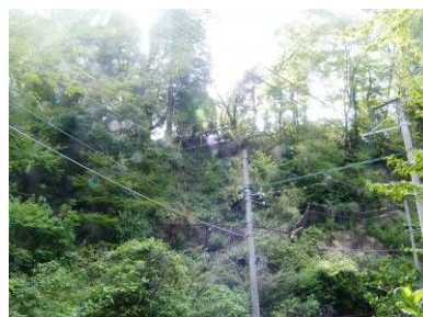
斜面防護工事
