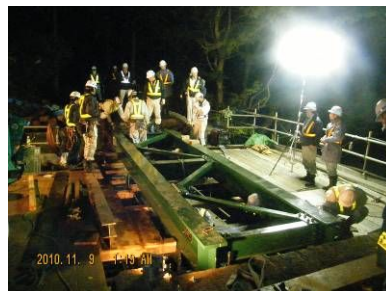
架け替え工事中の姫ノ水橋梁
