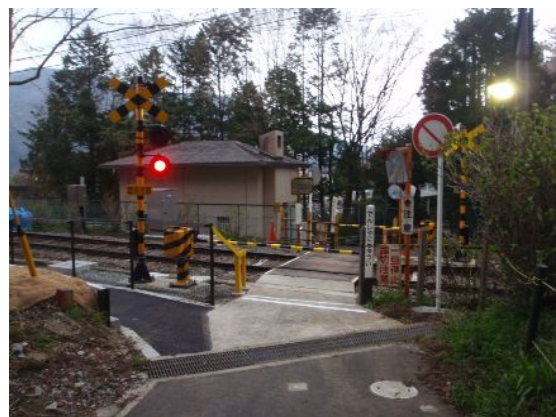
踏切保安度向上工事
