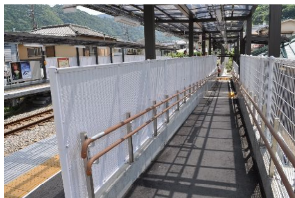
新設されたスロープ
